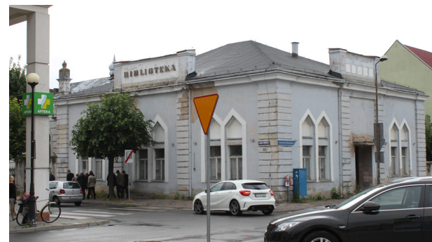
8 Das Schulhaus, auch Sitz der einst berühmten Koniner Bibliothek (Bes-Medesh, um 1870) an der Straßenecke zum ehemaligen Tepper Marik, dem Zentrum des Schtetls.
