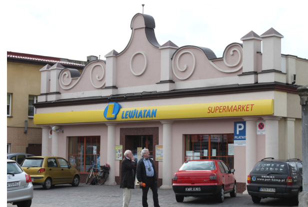
9 Das Gebäude der 1882 geplanten Mikwe neben der Synagoge. Es ist wahrscheinlich, daß unter dem heutigen Supermarkt die tieferliegenden Bauteile der Mikwe erhalten sind.
